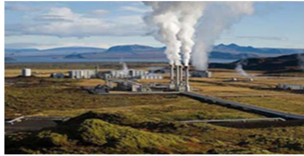
Hình 3. Nhà máy Điện địa nhiệt đầu tiên tại Đakrông - Quảng Trị.
