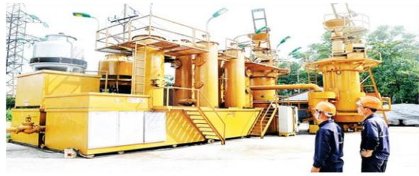
Hình 4. Nhà máy điện rác Gò Cát.
