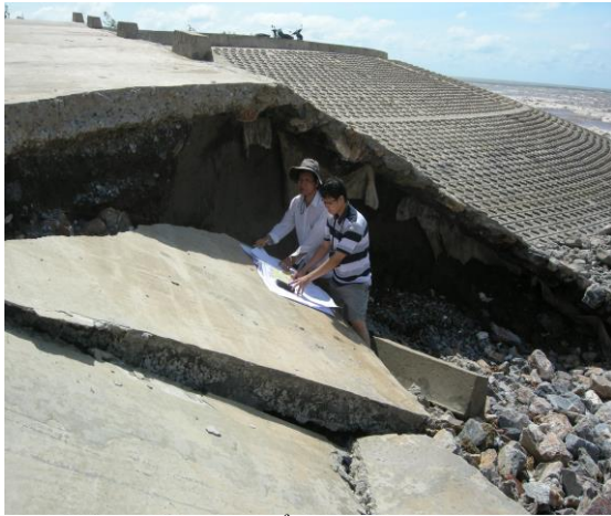
Ảnh1. Khảo sát tại điểm sạt lở sau cơn bão số 2 (22.6.2013), đê Hải Thịnh- Hải Hậu, Nam Định
