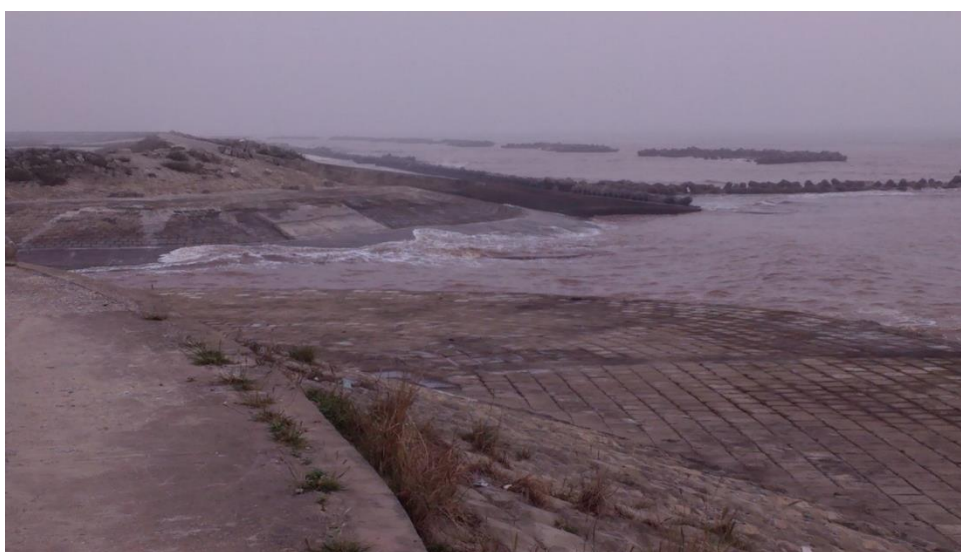
Hình 4. Hệ thống đê, kè được xây dựng để chống lại hiện tượng sạt lở đê biển tại xã Bạch Long, huyện Giao Thủy, tỉnh Nam Định
