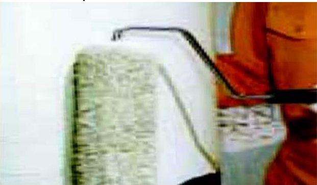
b. Sơn bảo vệ bề mặt tẩm FRP
