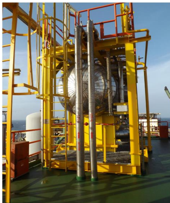
Hình 5. Thiết bị thu hồi nhiệt từ hệ thống khí xả của tuabin khí phát điện trên giàn bơm ép vỉa PPD - 40.000.
