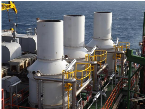
Hình 5. Thiết bị thu hồi nhiệt từ hệ thống khí xả của tuabin khí phát điện trên giàn bơm ép vỉa PPD - 40.000.
